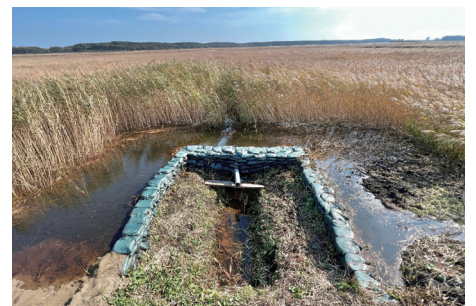
ダム工事後の状況。周囲に水が溜まり、湿原内部の水位が上昇している。
