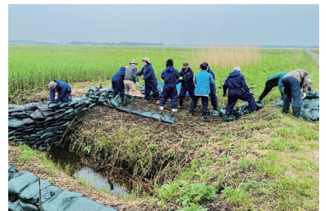
ダム設置工事の様子
